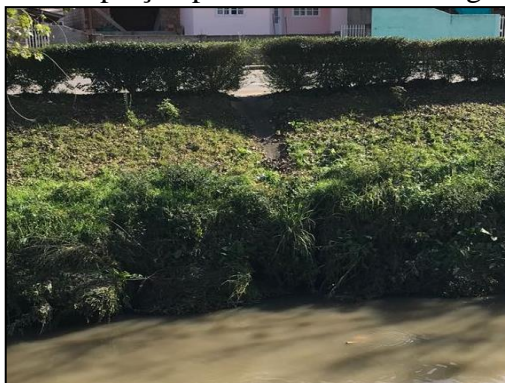
Figura 3 – Adaptação para escoamento da água pluvial
